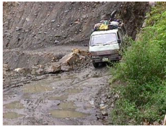
Derrumbes que cortan la carretera a Vilcabamba
