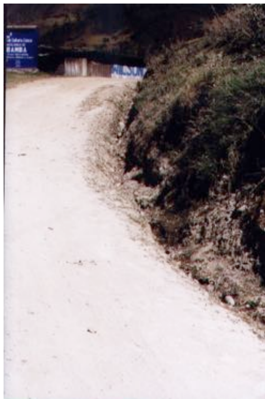
Foto 12: Detalle de una cuneta de Vilcabamba, muy rudimentaria.
