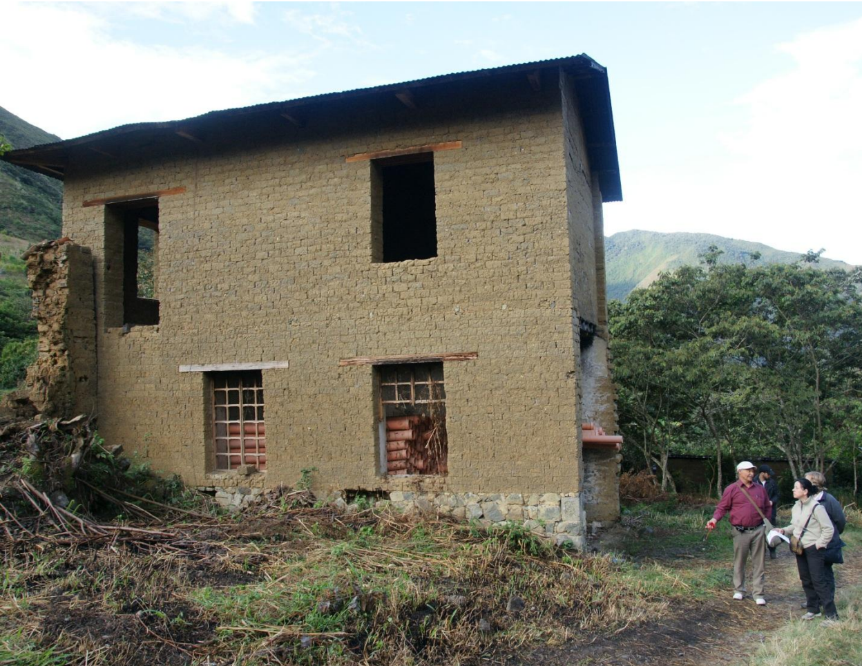
Exemplos de muro de carga de adobe con zócalo de pedra e dinteis de madeira en Paltaybamba e sen zócalo nen dintel en Huancacalle
