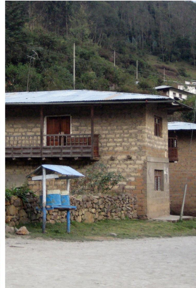
Exemplos de muro de carga de adobe con zócalo de pedra e dinteis de madeira en Paltaybamba e sen zócalo nen dintel en Huancacalle
