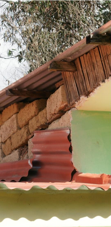
Exemplo de cuberta con estrutura de madeira e cobertura de calamina en Huancacalle
