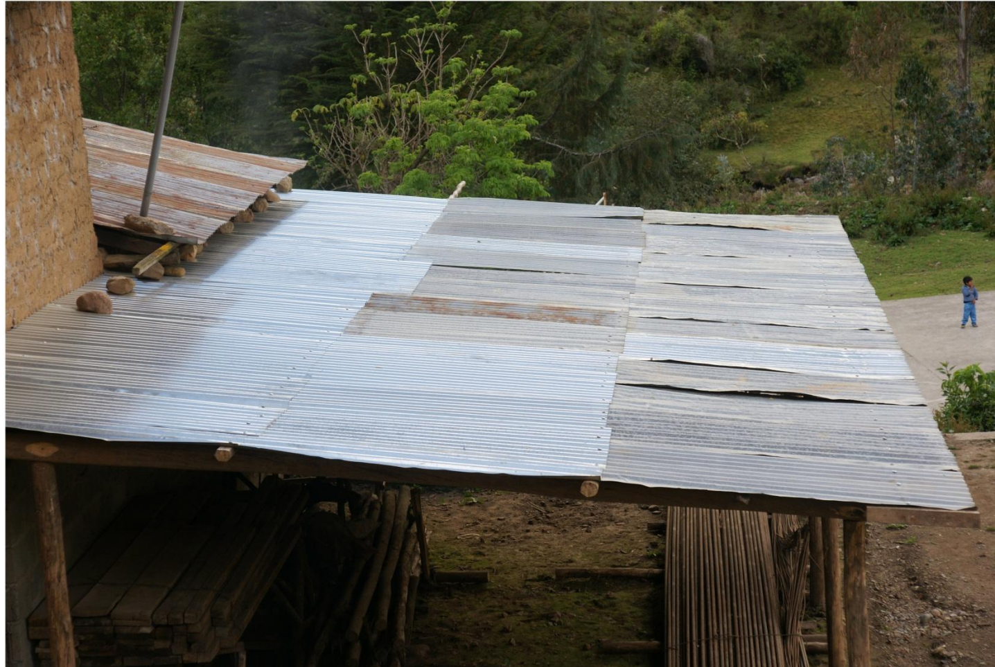
Exemplo de cuberta con estrutura de madeira e cobertura de calamina en Huancacalle
